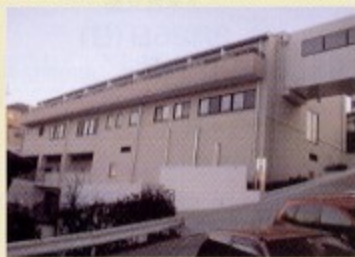
平成18年11月東館竣工
